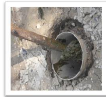
Gambar 8. Hasil timbunan sampah organik dalam Lubang Resapan Biopori
