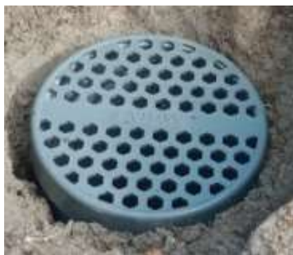
Gambar 3. A. Penutup yang dibeli sudah berlubang, tipis dan mudah pecah bila terlindas ban mobil dan motor, atau terinjak pejalan kaki. B. penutup yang tebal, dilubangi 4-5 buah lebih kuat dari pada yang A
