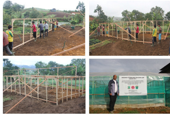
Gambar 3. Pembangunan Screen House untuk Penangkaran Benih Kentang
