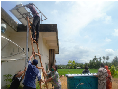
Gambar 6. Unit panel surya dan alat control DC
